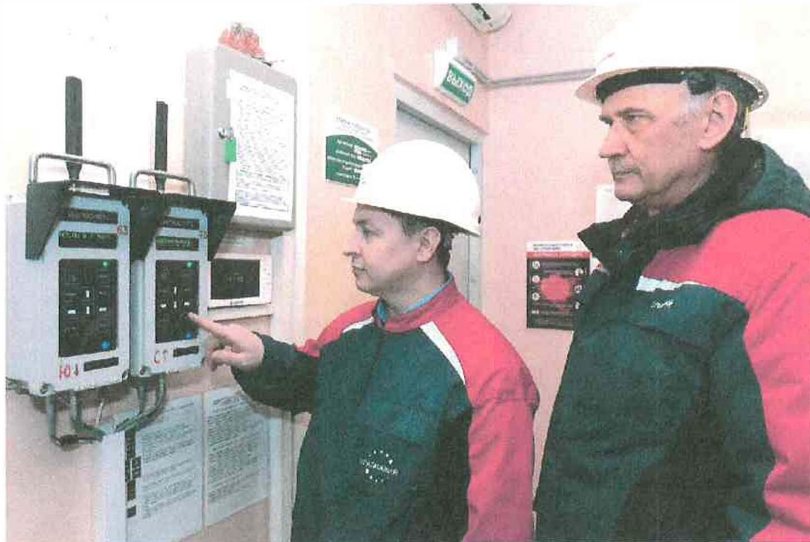
Сотрудники производственного участка шахтного подъёма рудника БКПРУ-4 – заместитель начальника Александр Миронов (слева) и механик Сергей Малютин: «Блок управления показывает, что канат проверен дефектоскопом «Интрос-Авто», индикатор горит зелёным – канат исправен»
